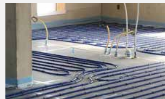
Je vloer ligt vol met het leidingwerk van o.a. de verwarming. Boor of bevestig dus nooit iets in de vloer. De kans is heel groot dat je een leiding raakt.
