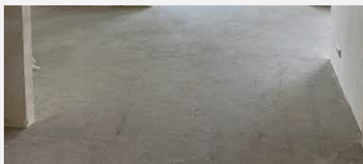
Afwerkloer van anhydriet.
