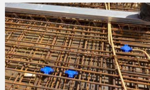
In dragende wanden en vloeren wordt heel veel wapening aangebracht. Dat zorgt ervoor dat we niet overal installatiepunten en deze exact op de maatvoering kunnen aanbrengen.
